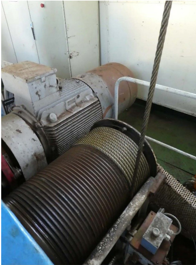
Het hijslierwerk. Foto: Helmig Kleerebezem
