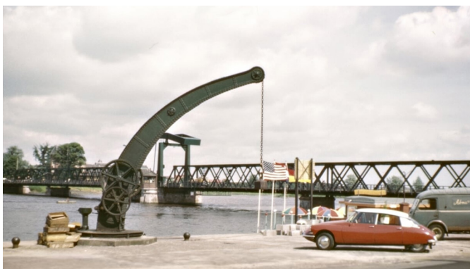
Foto's boven: De oorspronkelijke kraan op de IJsselkade in Kampen. Bron: Internet
